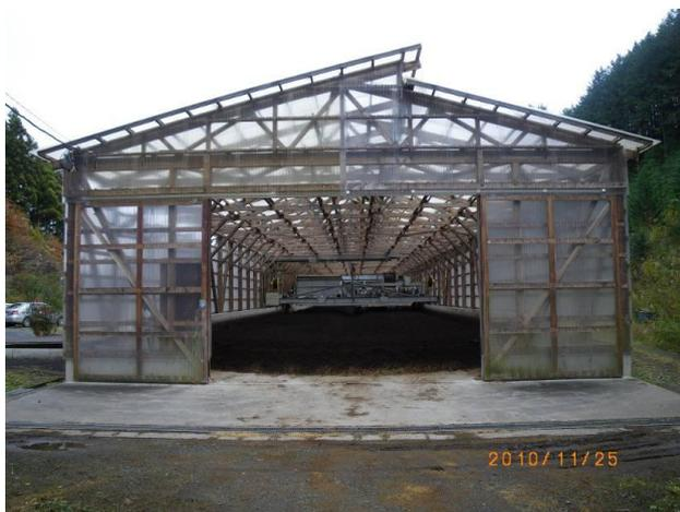
写真1：堆肥攪拌装置と堆肥舎
