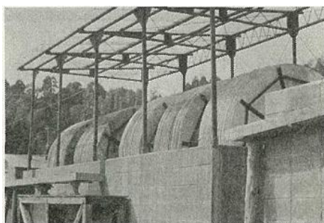
図 5-24 回転円板式排水処理装置
