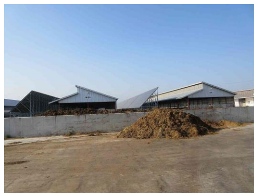
畜舎と太陽光発電設備
