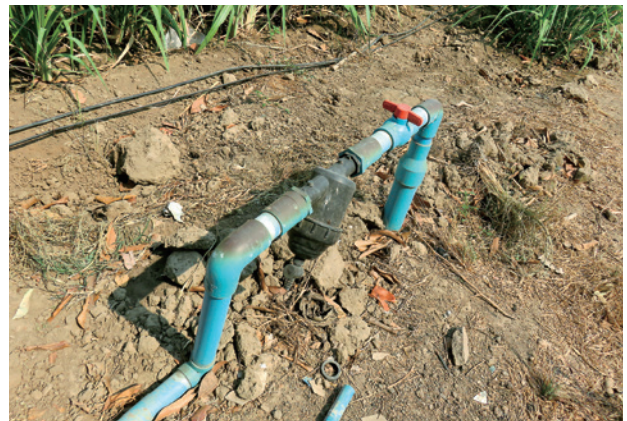
コラム1－写真3 貯水ポンプ
