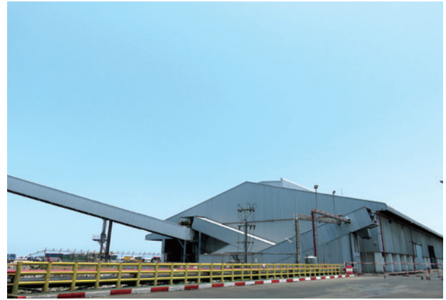
写真5 同港の粗糖の保管倉庫
