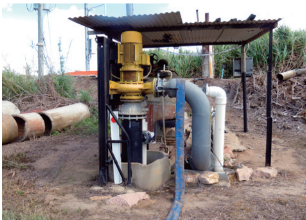
コラム2-写真3 河川からかんがい用水をくみ上げるポンプ
