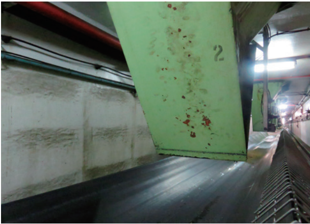
写真5 粗糖を船舶まで運ぶ倉庫地下のベルトコンベア
