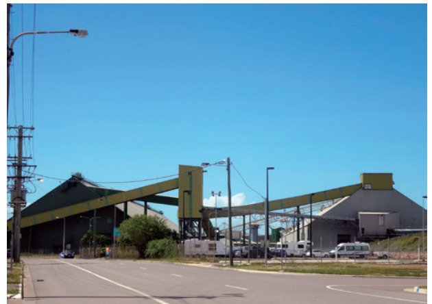
写真2 砂糖の保管倉庫 2棟で合計31万5000トンを保管。
