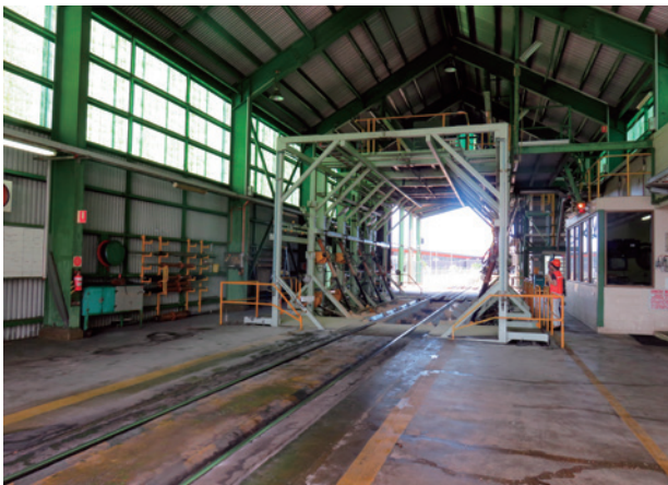
写真1 引き込み線が敷かれた搬入棟
