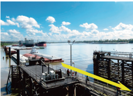
コラム2 写真5 バージの搬入場所への進入口。
