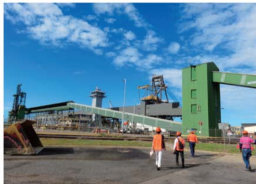
写真6 計量棟（右側）とシップローダー（左側）
