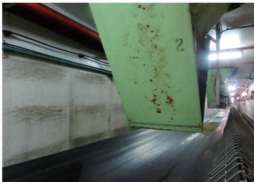
写真5 粗糖を船舶まで運ぶ倉庫地下のベルトコンベア
