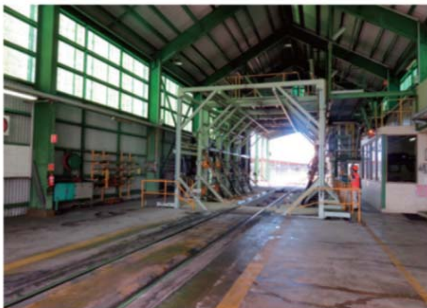
写真1 引き込み線が敷かれた搬入棟
