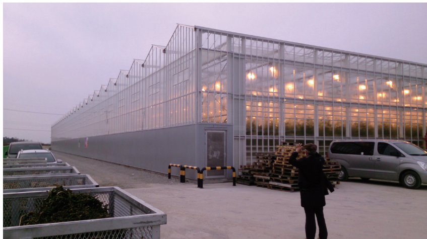
写真3 大型パプリカ生産施設
