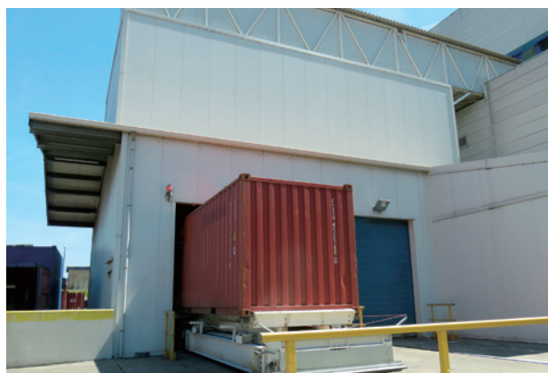
コラム2-写真5 輸出形態②バルクコンテナ (閉鎖された倉庫内までコンテナがコンベア上で移動し、コンテナ内のインライナー〈コンテナサイズの袋〉に、てん菜糖が全自動で充填される)
