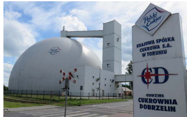
K S C社 Dobrzelin工場の砂糖サイロ（保管能力5万トン、同工場の2016/17年度の砂糖生産量7万5000トン）
