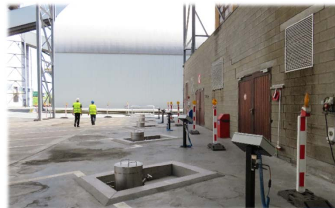
トラック搬入スペース
