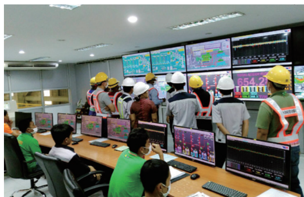
写真13 バガスを利用したバイオ電力工場の管理室
