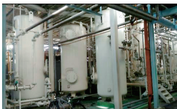
写真6 工場内の様子
