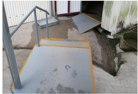
写真4 場内の手すりや階段は全て従業員による手作り
