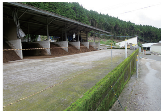
写真5 場内の安全用ロープ
