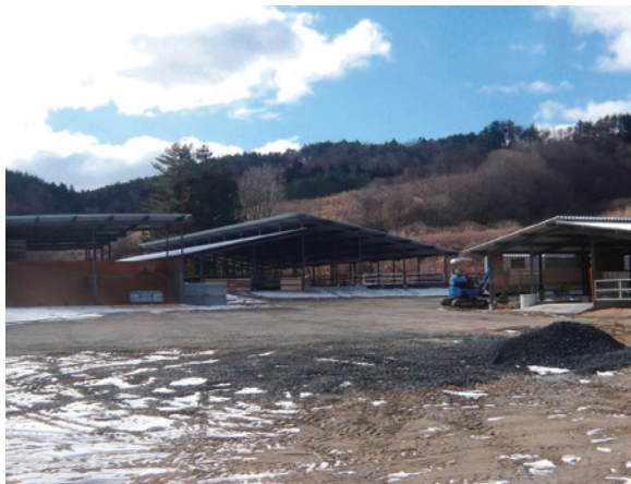
写真4 自力施工中の牛舎（奥が放牧予定地）
