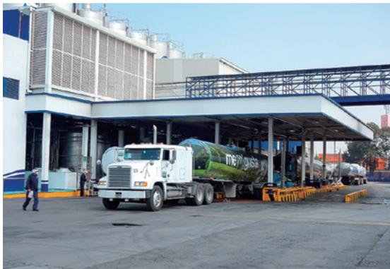
写真12 ローリーから工場への生乳受け入れ。ローリーは、タンク1つで3万5000リットル、二つ連結した場合6万~6万5000リットル。
