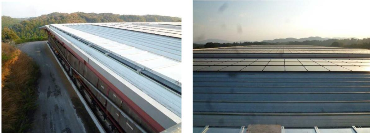
写真4 牛舎の屋根全面に設置された太陽光パネル
