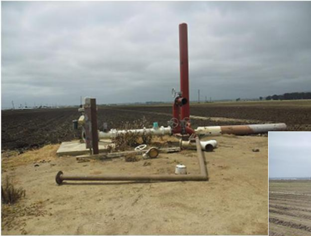
地下水をくみ上げる井戸
