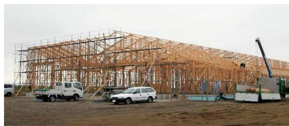
写真2 木造牛舎建築の様子 (別海町:久保牧場)
