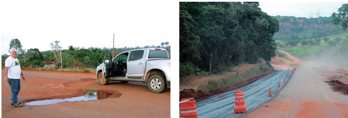
写真6 国道163号線（左：未舗装、右：舗装中） 舗装によりスピードアップが可能に（PRO LOGISTICA提供）
