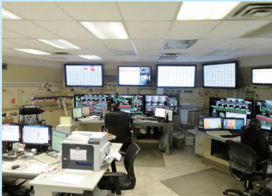
コラム2写真7 敷地内のコントロールルーム。搬入・積み込み・保管庫の動きをわずか3人体制でコンピューター管理。
