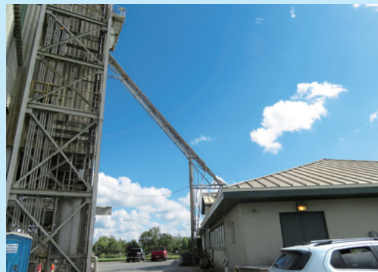
コラム2写真10 搬入ライン上から抽出されたサンプルが管理棟内検査室へ送られるライン。
