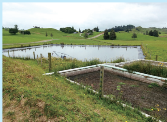
コラム写真2 家畜排せつ物は、一カ所にまとめられたうえで沈殿され、水分と固形分に（重力のみで）分離される。水分は夏場に、固形分は年に1回程度、ともに草地へ散布されている。
