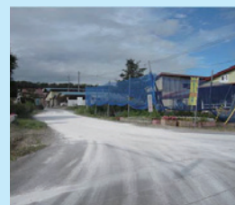
消石灰帯の設置
