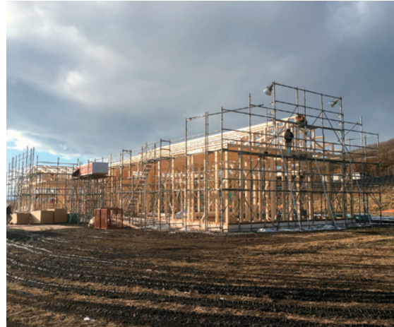
写真5 十勝川温泉に建設中の大型共同熟成庫
