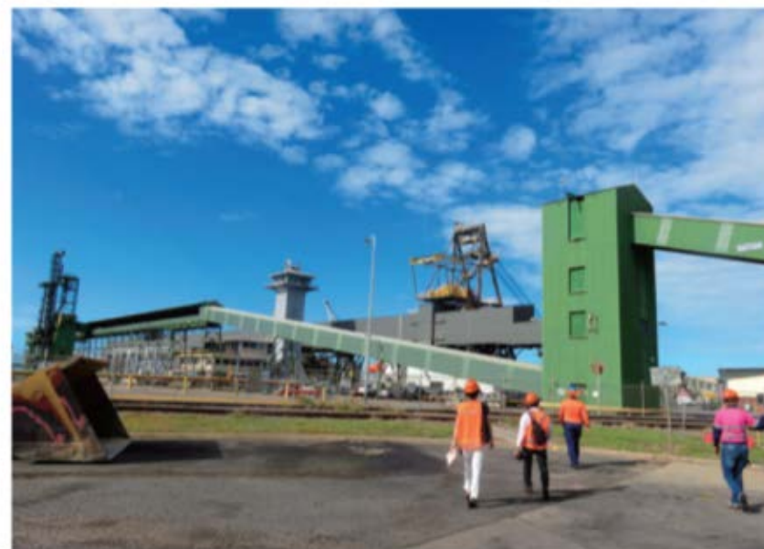
写真6 計量棟（右側）とシップローダー（左側）
