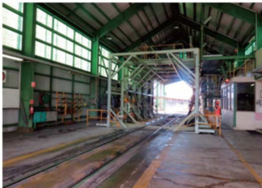
写真1 引き込み線が敷かれた搬入棟
