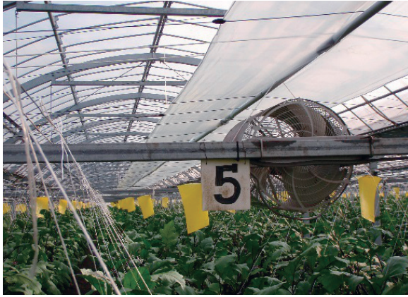
写真4 天井二層カーテンと循環扇
