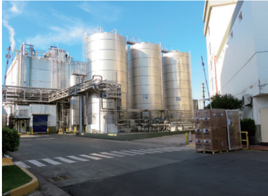
写真3 La Serenisima社のプラントの貯乳タンク、1本当たり250キロリットルの生乳が貯蔵できる
