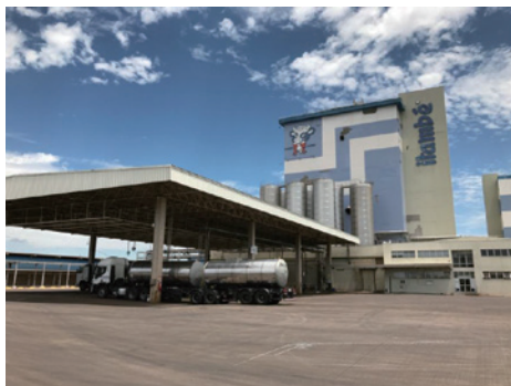
6階建て（約20メートル）の乾燥チャンバーの建屋
