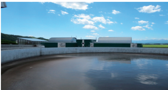
写真5 十勝新得バイオガス屈足プラントの概観。前方が貯留槽の池、後方が発酵槽の建物（JA新得町提供）
