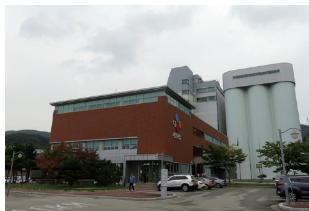
写真4 CJ第一製糖の梁山工場の外観 (右側の円柱の建物は小麦粉のサイロ)
