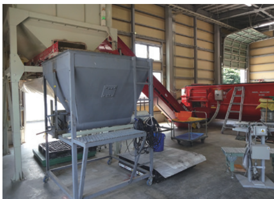
写真16 ゆりファームTMRセンター内の施設
