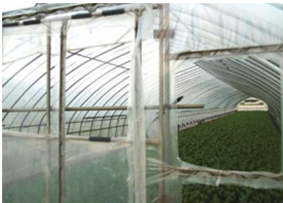
ハウス上部の窓が開く作りにし熱気を逃がす
