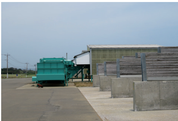
写真 島内にある精脱施設の一つ（中種子町） （緑色の建物内で原料茎とトラッシュに選別される）
