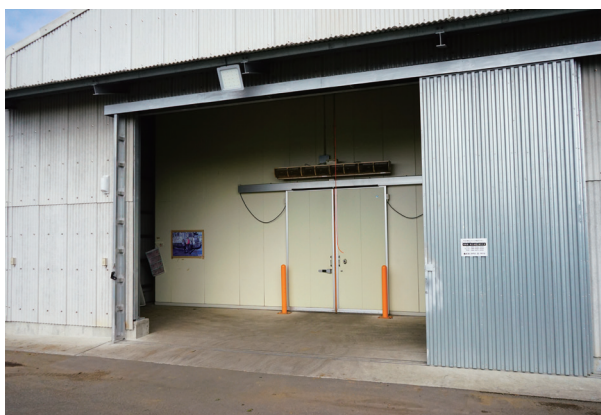
写真10 冷蔵倉庫（外観）
