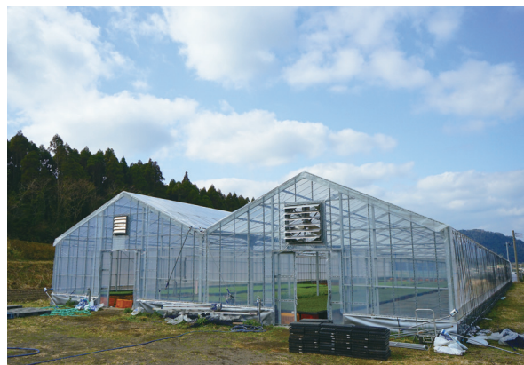
写真5 育苗ハウス (外観)
