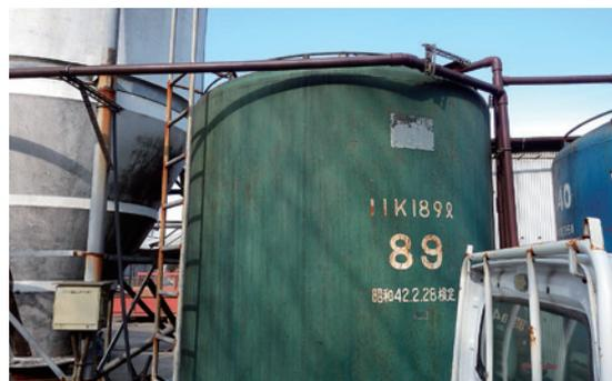
写真9 大西海Fの職員が設計・造設したシロップかす専用のタンク
