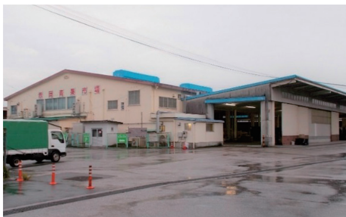
写真1 赤岡市場の外観
