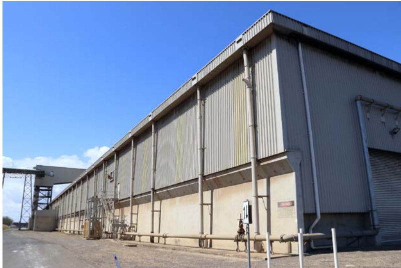
巨大な貯蔵庫(3棟あるうちのひとつ)
