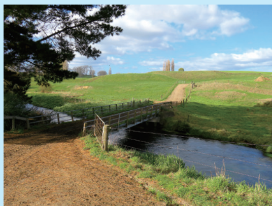
コラム1－写真6 農場内の橋の様子
