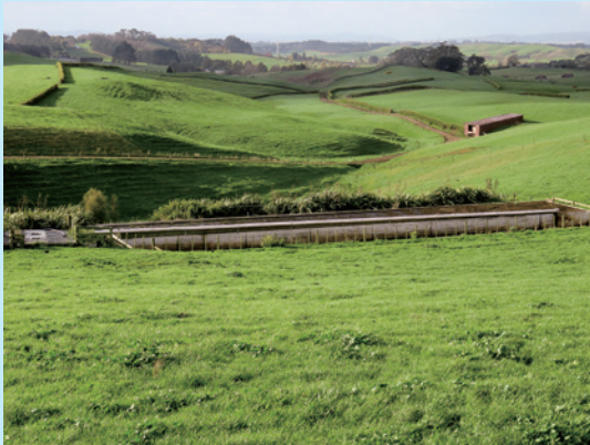
コラム3－写真1 固液分離施設
