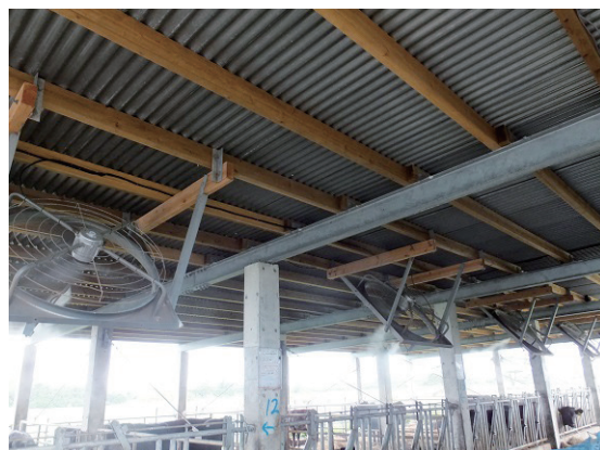
写真5 農さん自身が施工した屋根部分とそこに設置したファン
