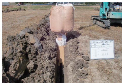
写真2 水田の暗渠工事
