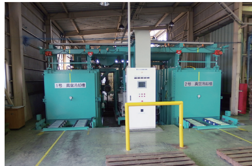
写真4 2017年に更新した真空予冷機
