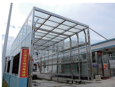
写真19 広東省の飼料メーカーの噴霧式車両消毒装置。「車両消毒通路を利用してください」と書かれており、進入する車両は全てここで消毒を行う。
