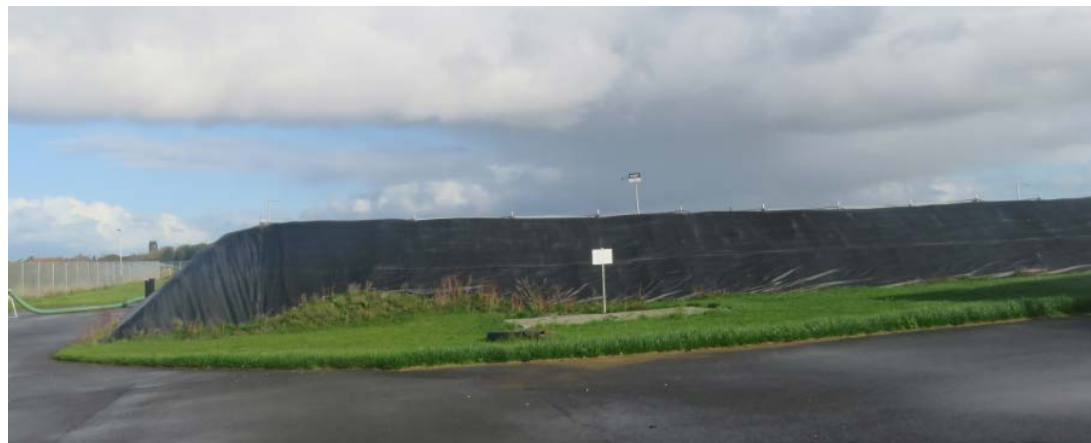
消化液の液体分の保存施設
