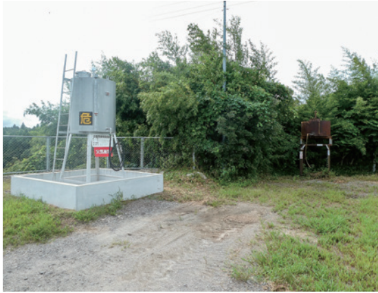
写真3 JGAP認証取得に当たり、老朽化したタンクを新設
