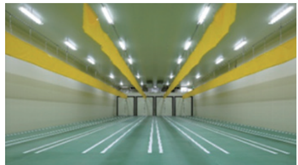
写真10 平成30年に完成した大型乾燥施設と乾燥庫内部
