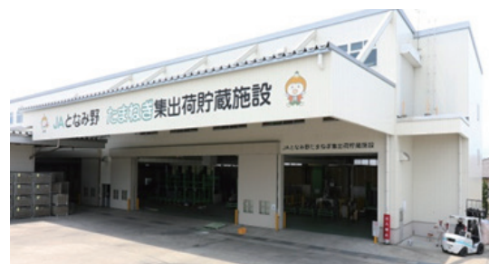
写真11 選別出荷施設
