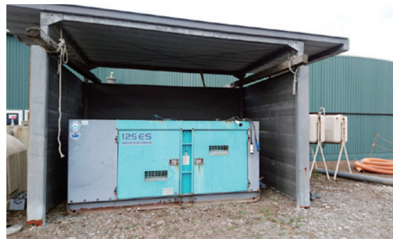
写真10 定置式自家発電機（サンエイ牧場提供）
