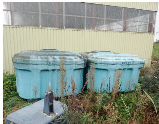
写真3 FRP製貯水タンク（太田牧場提供）
