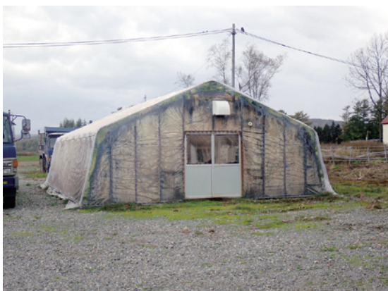
写真5 雑排水処理施設 (太田牧場提供)
