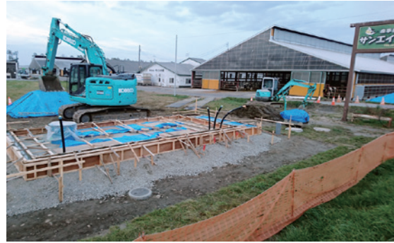
写真11 建設中の貯水槽（サンエイ牧場提供）
