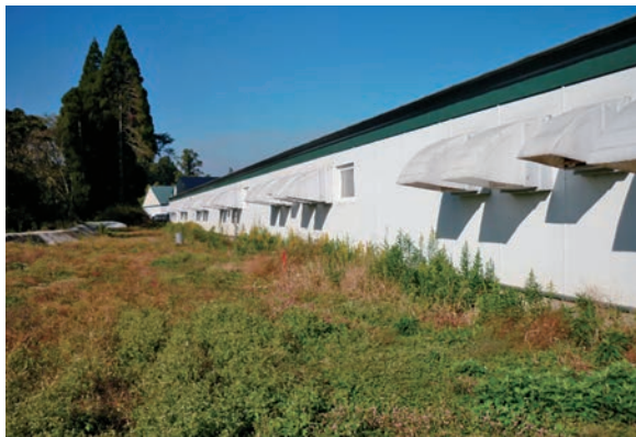
写真1 ウィンドレス豚舎の換気扇
