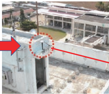
(1) 可搬式基地局を高い構造物に固定し、固定基地局とした。
