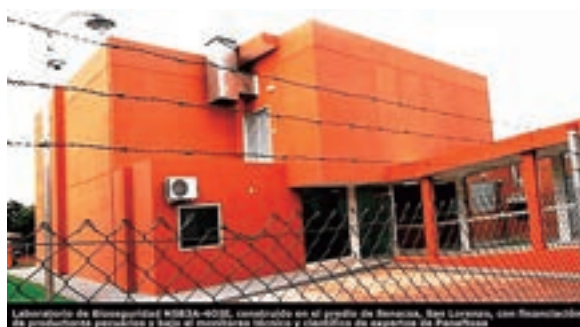
写真 2 BSL 3A-4 OIE検査棟
