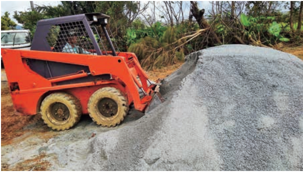
②pH調整のため石灰を散布している様子
