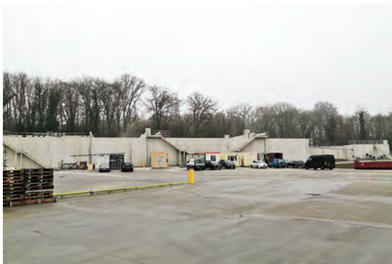
写真4 工場の水のリサイクルを行っている設備
