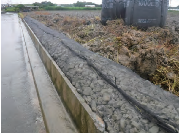
写真8 スーパーソルが農地に設置された様子 (糸満市)
